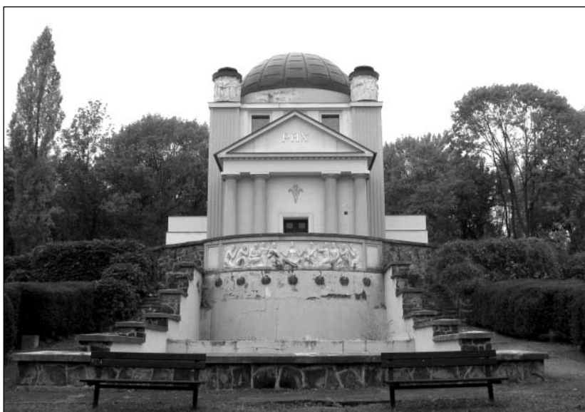
(Staré) krematorium v Mostě – „chrám pokroku“ z roku 1924 (architekt August Kirstein). Po ukončení provozu v sedmdesátých letech mělo sloužit jako kolumbárium, dnes je v něm umístěna expozice obětí pracovních a koncentračních táborů druhé světové války (foto Zdeněk R. Nešpor, 2009)
