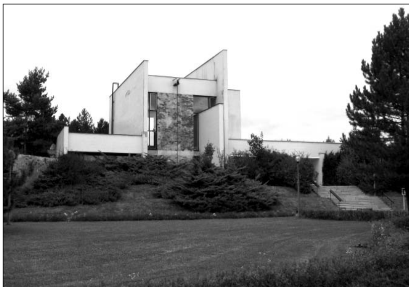
Krematorium v Šumperku z roku 1979 projektoval tehdy proskribovaný architekt Petr Brauner (foto Zdeněk R. Nešpor, 2009)
