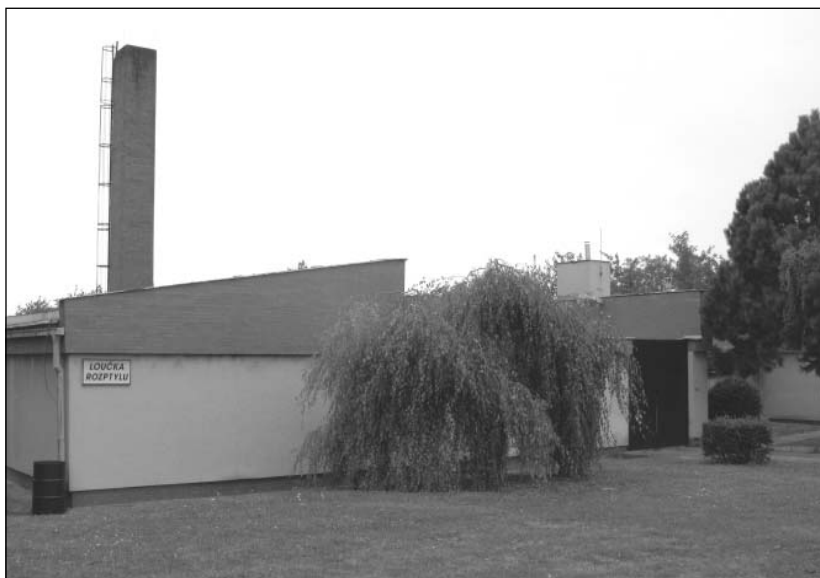
„Továrna na spalování mrtvol“: krematorium v Mělníku z roku 1985 podle návrhu architekta J. Kosíka (foto Zdeněk R. Nešpor)
