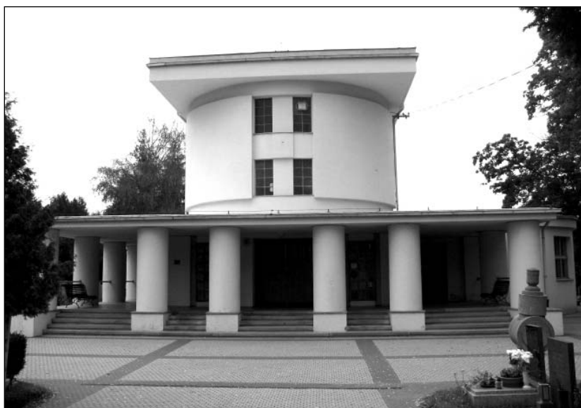
Krematorium v Nymburku – výjimečná stavba meziválečného purismu z roku 1924 architektů Bedřicha Feuersteina a Bohumila Slámy (foto Zdeněk R. Nešpor, 2009)
